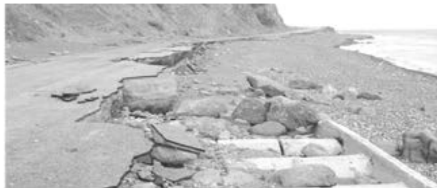
Carretera ubicada al sur de la Sierra Maestra afectada por el oleaje de un evento hidrometeorológico. FOTO: ARCHIVO
