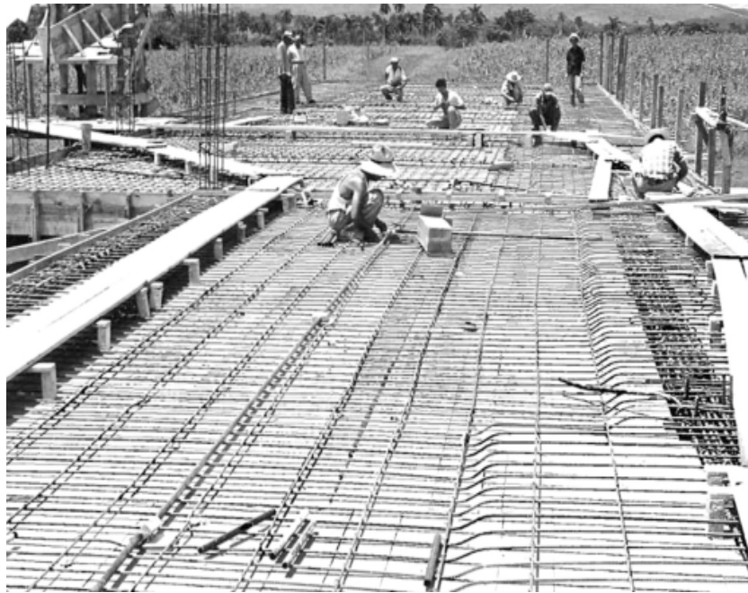
Fig. 7. Vista de la construcción del edificio
