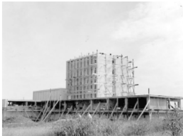
Fig. 9. Vista general de la construcción del edificio, casi en la etapa final.
